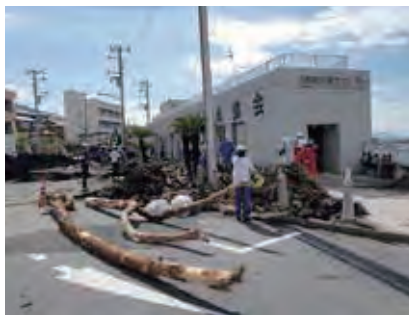
平成25（2013）年、台風第26号通過後の中学生による土砂等の片付け（大島町）
