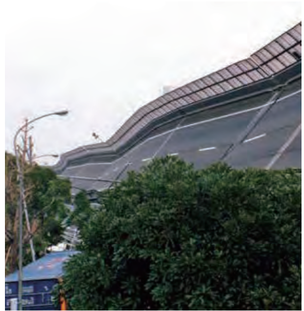
橋脚からなぎ倒された高速道路【阪神・淡路大震災 平成7（1995）年1月】 （提供：神戸市）
