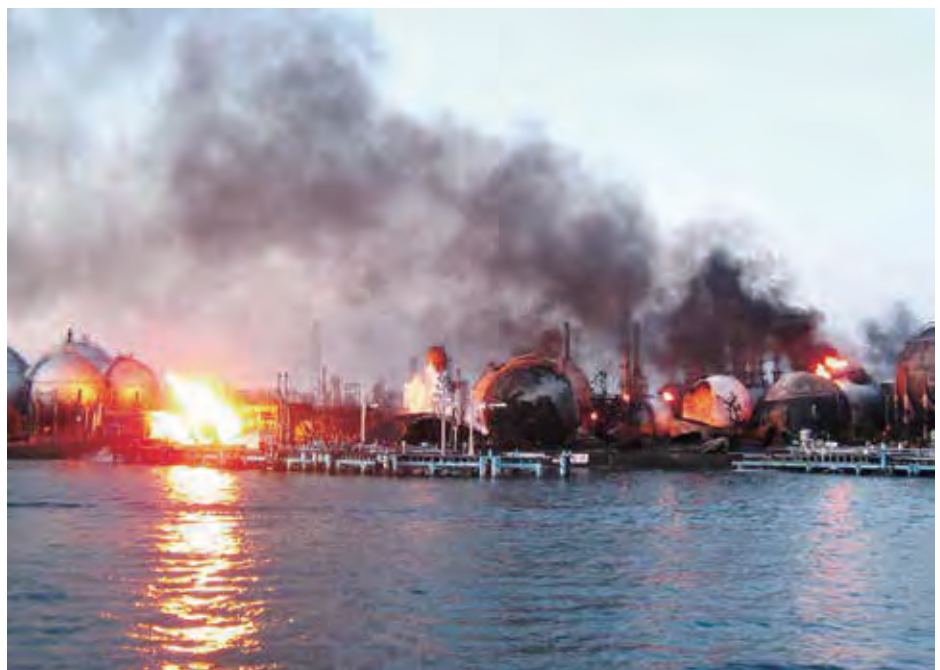
地震によるガスタンクの火災【東日本大震災 平成23（2011）年千葉県市原市】
