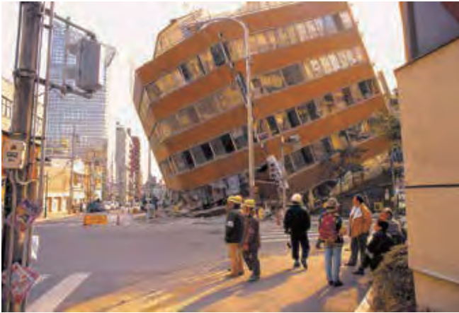
1階部分が崩れ、傾いたビル【阪神・淡路大震災 平成7（1995）年1月】
