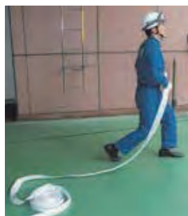
③ 放水を担当する人は、放水口・ホース・筒先を結合し、火元までホースを伸ばし、ポンプを操作する人に放水の準備ができた合図をします。
