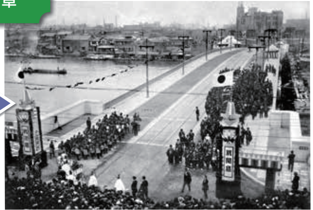
昭和5（1930）年12月21日 あづまばし 吾妻橋開通の様子
