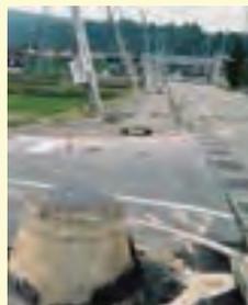
液状化で突出したマンホールと傾いた電柱 (平成 16 年 新潟県中越地震)
