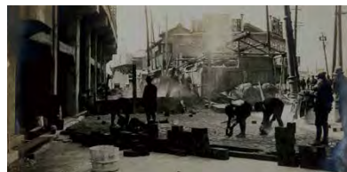
舗装道路工事
