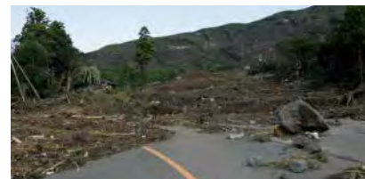
平成25(2013)年 台風第26号による伊豆大島の土砂災害
