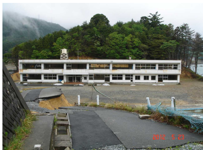
谷川小学校全景
