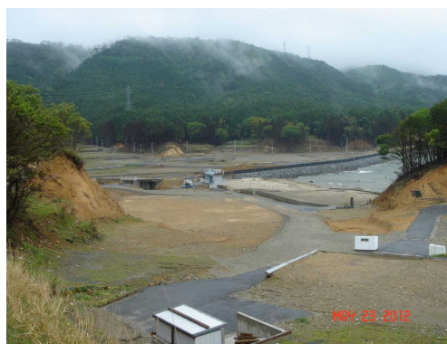
谷川小学校周辺。集落全てが流された。
