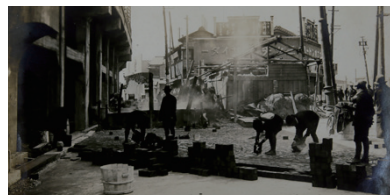
舗装道路工事
