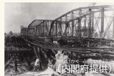
関東大震災時の永代橋
