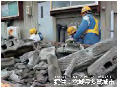
ブロックべいが たおれる 提供：宮城県多賀城市
